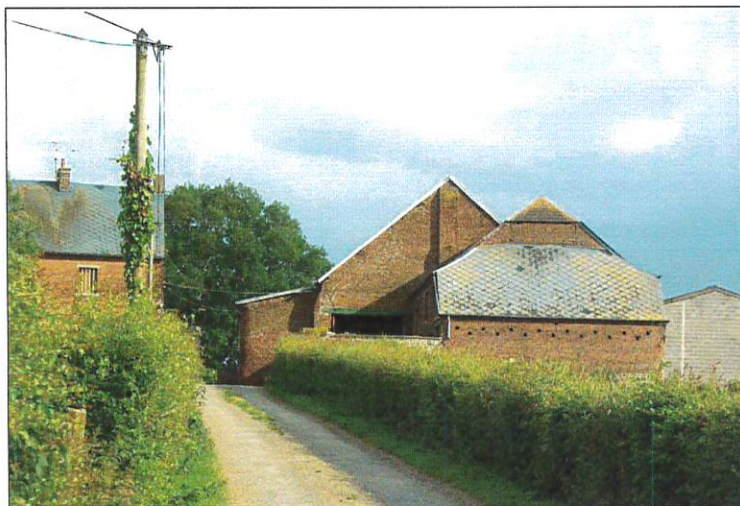
La ferme Riche présente des atouts architecturaux intéressants pour une réhabilitation de cet espace.
